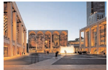
Bild 18 Seite 110 Metropolitan Opera House, New York City/USA
