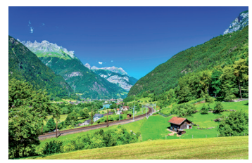
Bild 24 Seite 358 Gotthard-Basistunnel, Schweizer Alpen Bei Erstfeld gräbt sich der Gotthard-Basistunnel in die Alpen.
