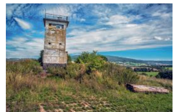
Bild 9 Seite 80 Dieser alte Wachturm diente als Führungsstelle. Er befindet sich auf einem Hügel unweit von Hundsbach.
